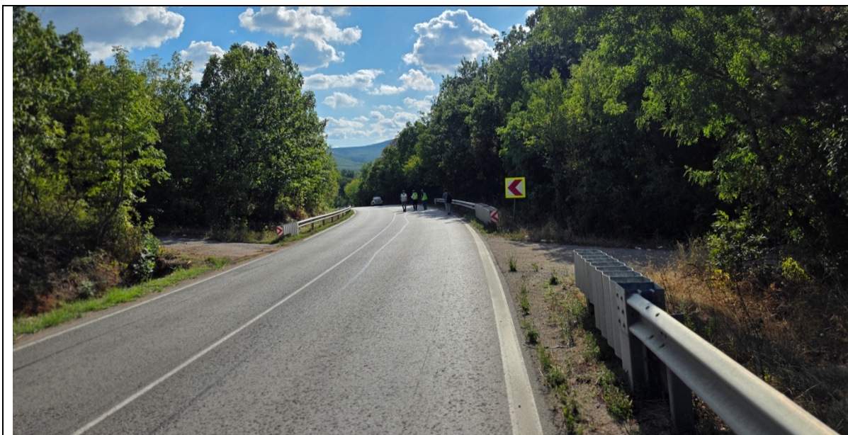
Общ изглед към двата входа/изхода при селскостопански/горски път. Изглед с посока на движение от гр. Монтана към гр. Видин
