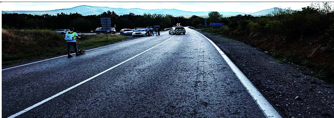
Изглед към пресичането с второстепенен път отляво за с. Каменна Рикса (посока на движение от гр. Монтана към гр. Видин). От това изображение е видна липсата на стрелките М11.
