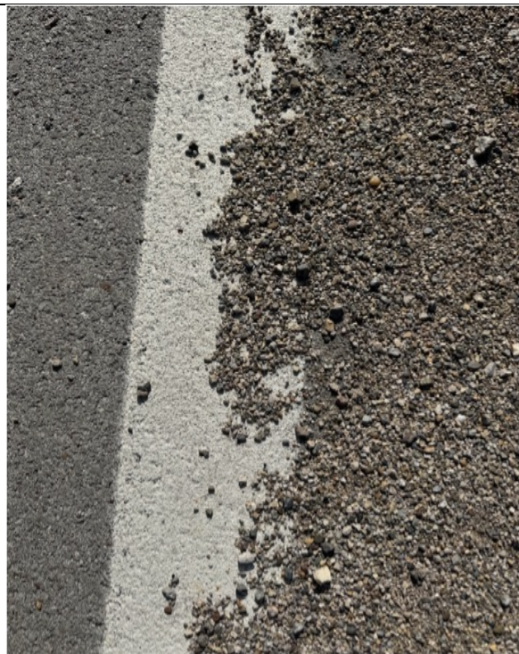
Общо състояние на крайна непрекъсната линия М1 при посока на движение от гр. Видин към гр. Монтана
