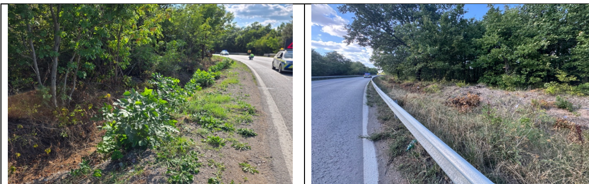
Състояние на земните окопи в обхвата на изследването
