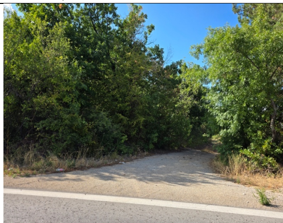
Видимост при отбивката в северна лента при посока на движение от гр. Монтана към гр. Видин. Няма поставен знак Б2
