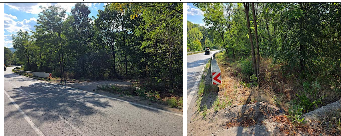
Нерегламентиран вход/изход в северната лента на път I-1 при посока на движение от гр. Монтана към гр. Видин. Състояние на растителността и видимостта о обхваща на образуването нерегламентирано кръстовище.
