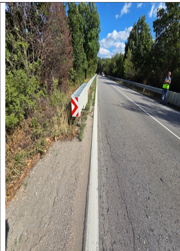
Пример за почистване на растителността зад ОСП - южна лента с посока на движение (гр. Монтана → гр. Видин)
