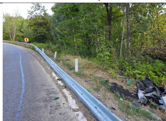
Повреден участък от ОСП в дясно от платното за движение (посока от гр. Видин към гр. Мездра) при км 86+740 до км 86+851
