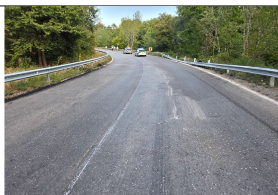
Общ изглед към ограничителна система за пътища (посока от гр. Видин към гр. Монтана)
