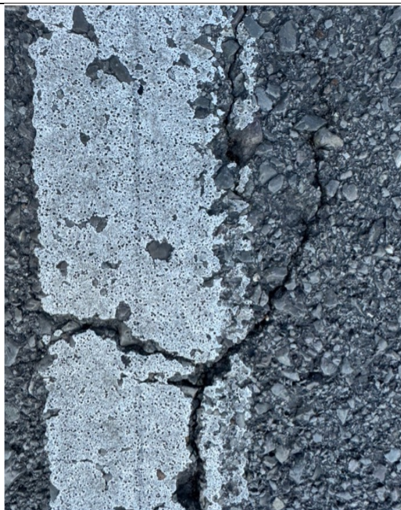
Общо състояние на крайна непрекъсната линия М1 при посока на движение от гр. Монтана към гр. Видин
