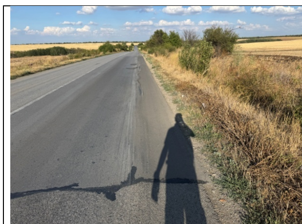
Състояние на крайната линия обозначаваща границата на платното за движение (дясно платно посока от гр. Бяла Слатина към гр. Кнежа). Снимката е заснета през м. Септември 2025 г. след обезопасяването на УКПТП
