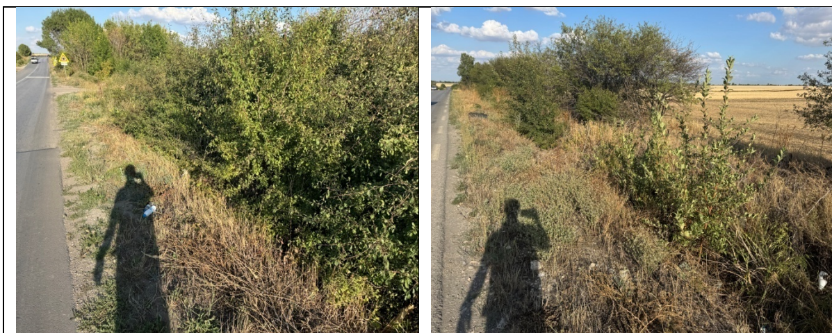
Състояние на откосите в изследвания участък (посока от гр. Бяла Слатина към гр. Кнежа)
