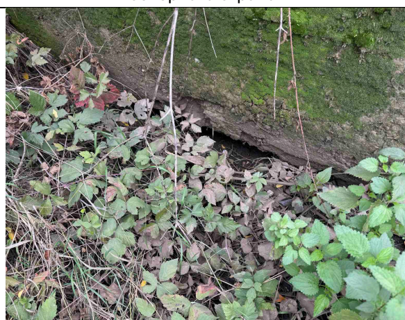
Състояние на водосток – изглед от северната на пътя (посока на движение от гр. Кнежа към гр. Бяла Слатина)
