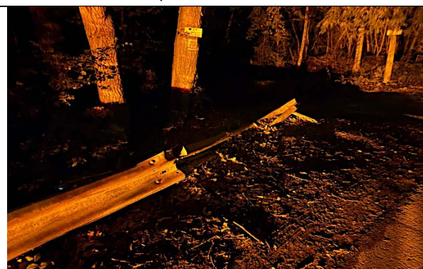
При огледа на ЕЦТП се установи, че липсват крайни елементи като зануляване (късо или дълго) или буфери/терминали. Това прави
