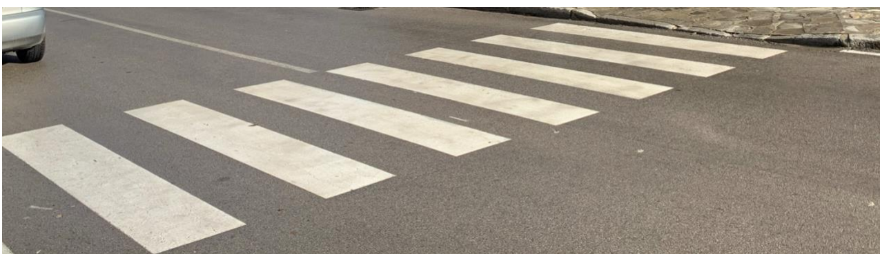
Пътната маркировка тип М8.1. противоречи на изискванията на Приложение № 10 към чл. 21, ал. 3 от наредба №2 за сигнализацията на пътищата с пътна варкировка
