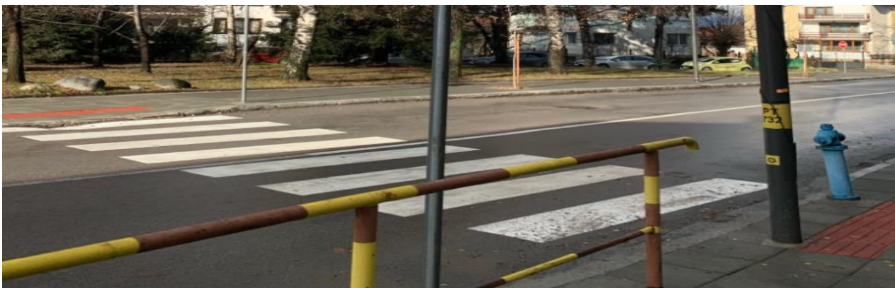
Пътната маркировка тип М8.1. противоречи на изискванията на Приложение № 10 към чл. 21, ал. 3 от наредба №2 за сигнализацията на пътищата с пътна варкировка
