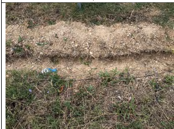
Установен на място канал, по който преминава захранващ кабел на осветлението.
