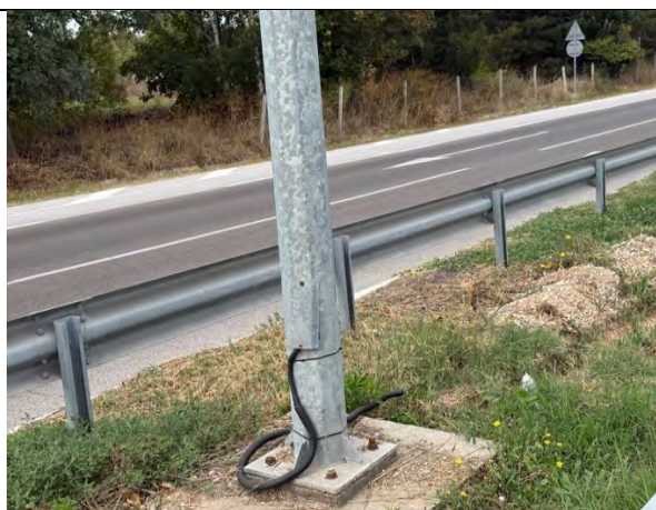
Захранващ кабел, който излиза от разкопния канал и се включва в носещия стълб на осветителното тяло
