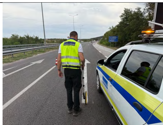
Измерване на стрелки М10 с мерително колело с цел установяване на съответствие с Приложение 11 чл.27, т. 1 от Н2
