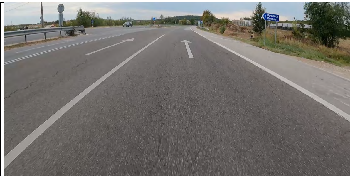
Общ изглед на състоянието на стрелките М10. Много ясно се вижда при стрелката указваща ляв завой от път I-5 към с. Крепост при посока на движение от гр. Димитровград → към гр. Хасково
