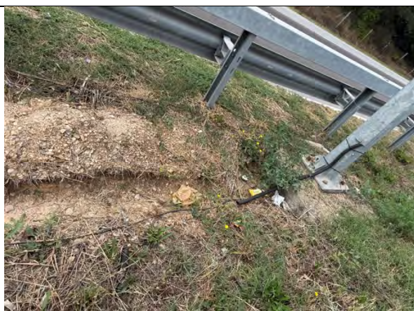
Установен на място канал, по който преминава захранващ кабел на осветлението.
