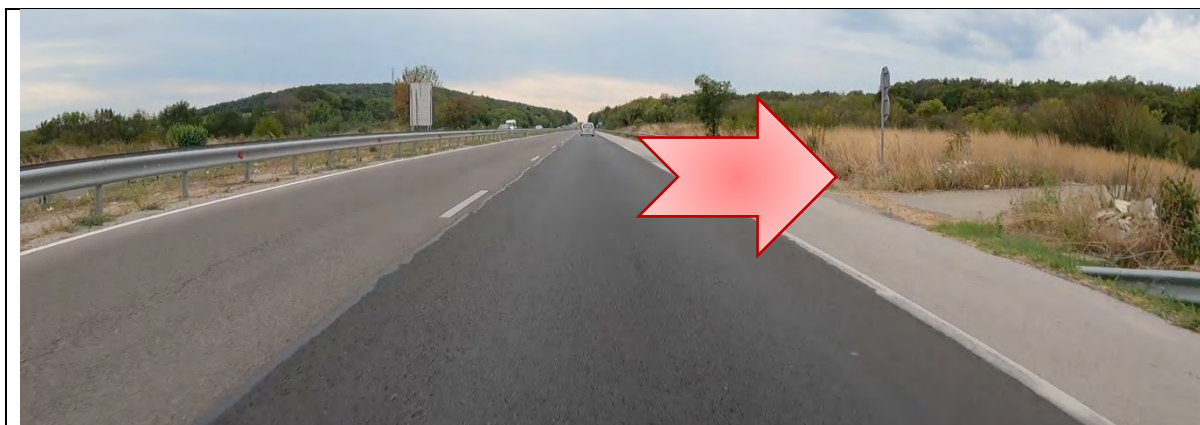
Нерегламентиран вход/изход при км 282+501, при който има поставени пътни знаци B2+Г2, които не фигурират в проекта за постоянна организация на движението.
