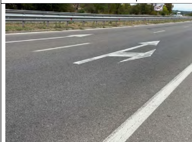
Състояние на стрелките с ясно видими петна и обезцветяване в средата при посока на движение от гр. Хасково към ← гр. Димитровград
